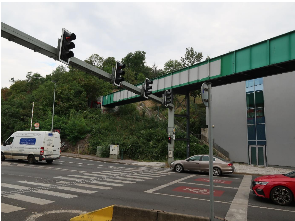
Obr.4 Pohled na druhou podpěru a první pilíř, pohled na park zprava
