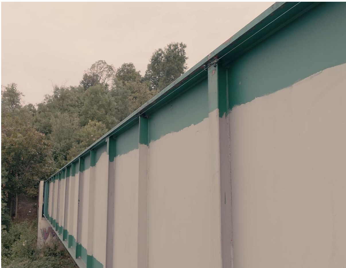
Obr.25 Pohled na kombinace povlaků na stěně pravého hlavního nosníku
