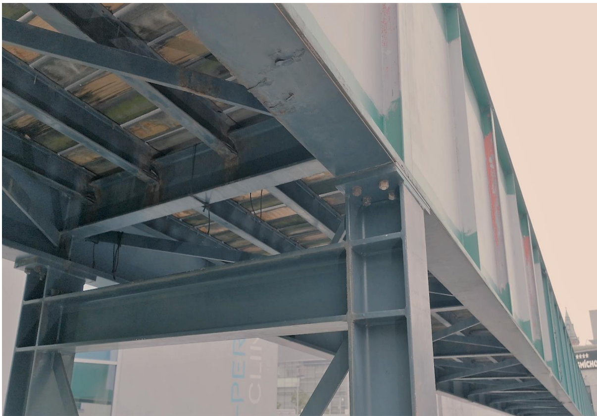
Obr.55 Pohled na uložení lávky na druhé podpěře, první pilíř, vpravo
