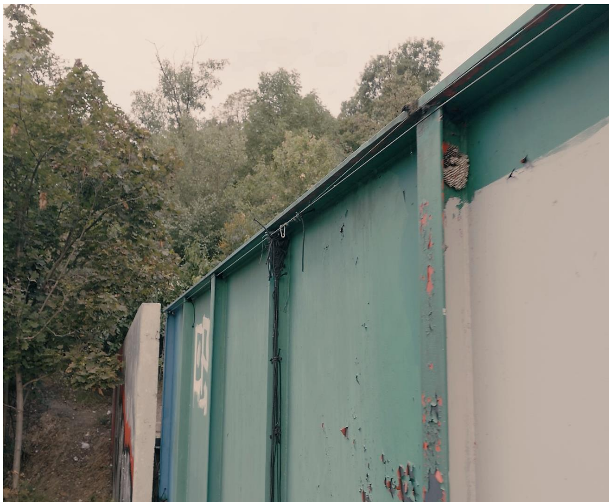
Obr.23 Pohled na úvazy lan a hnízda vos na pravém hlavním nosníku
