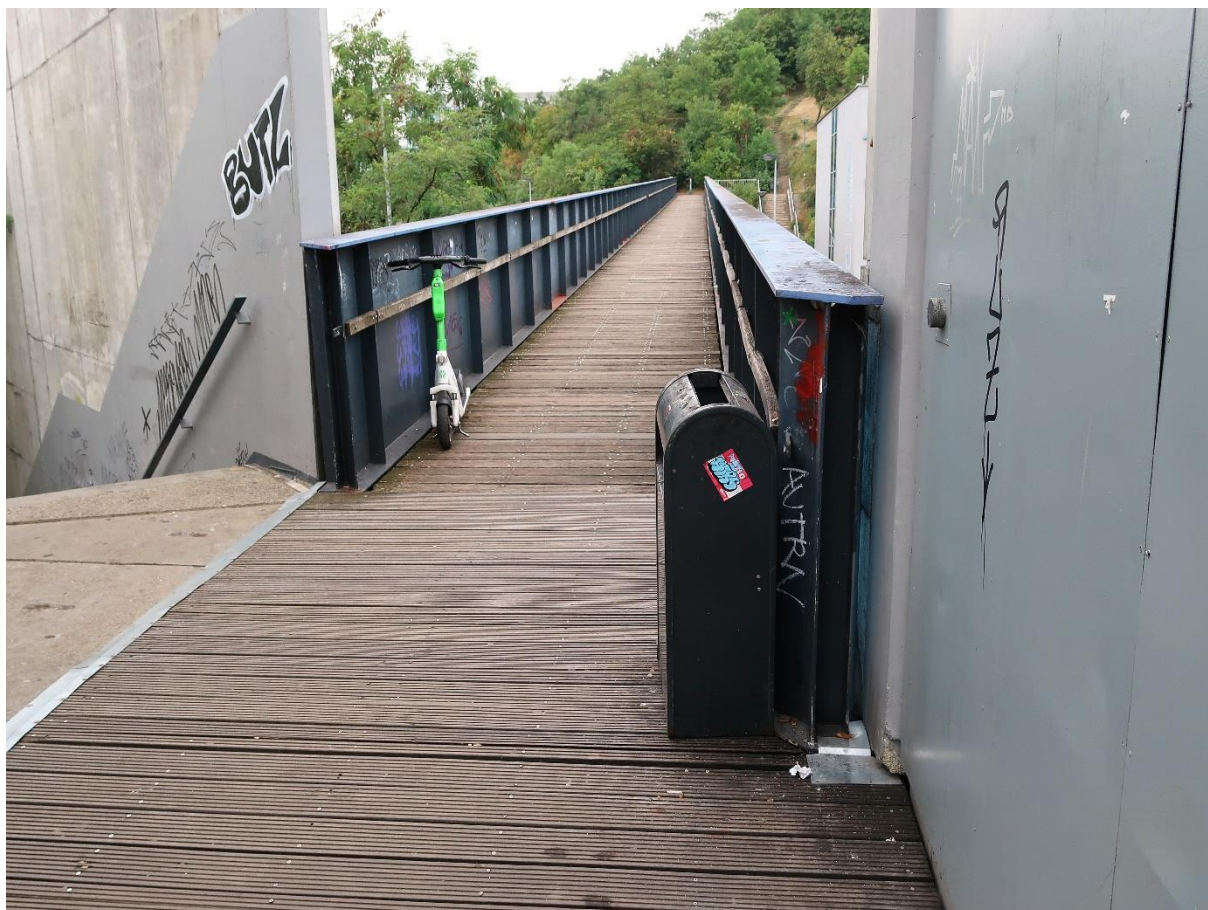
Obr.67 Pohled na opěru 2 bez mostního závěru s průběžnou podlahou
