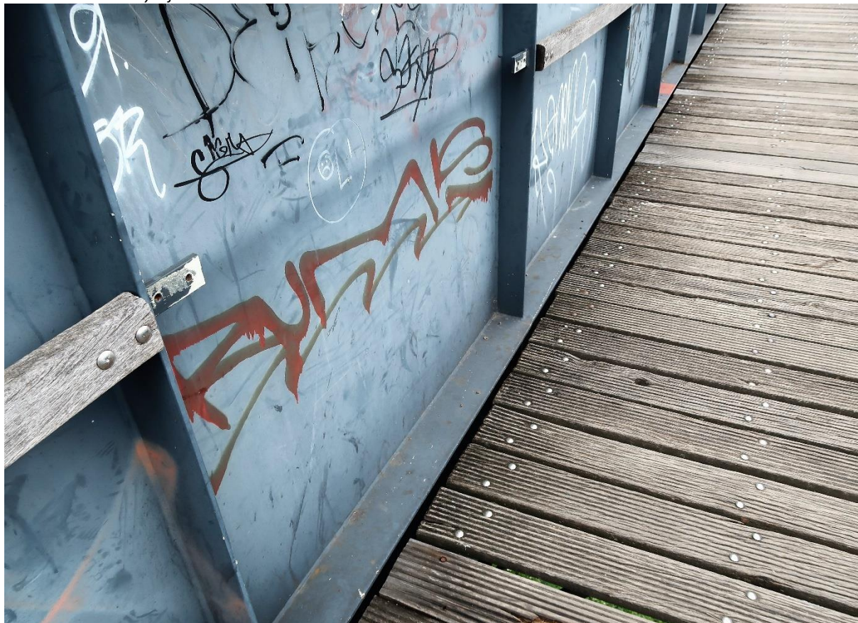
Obr.78 Pohled na chybějící madla zábradlí
