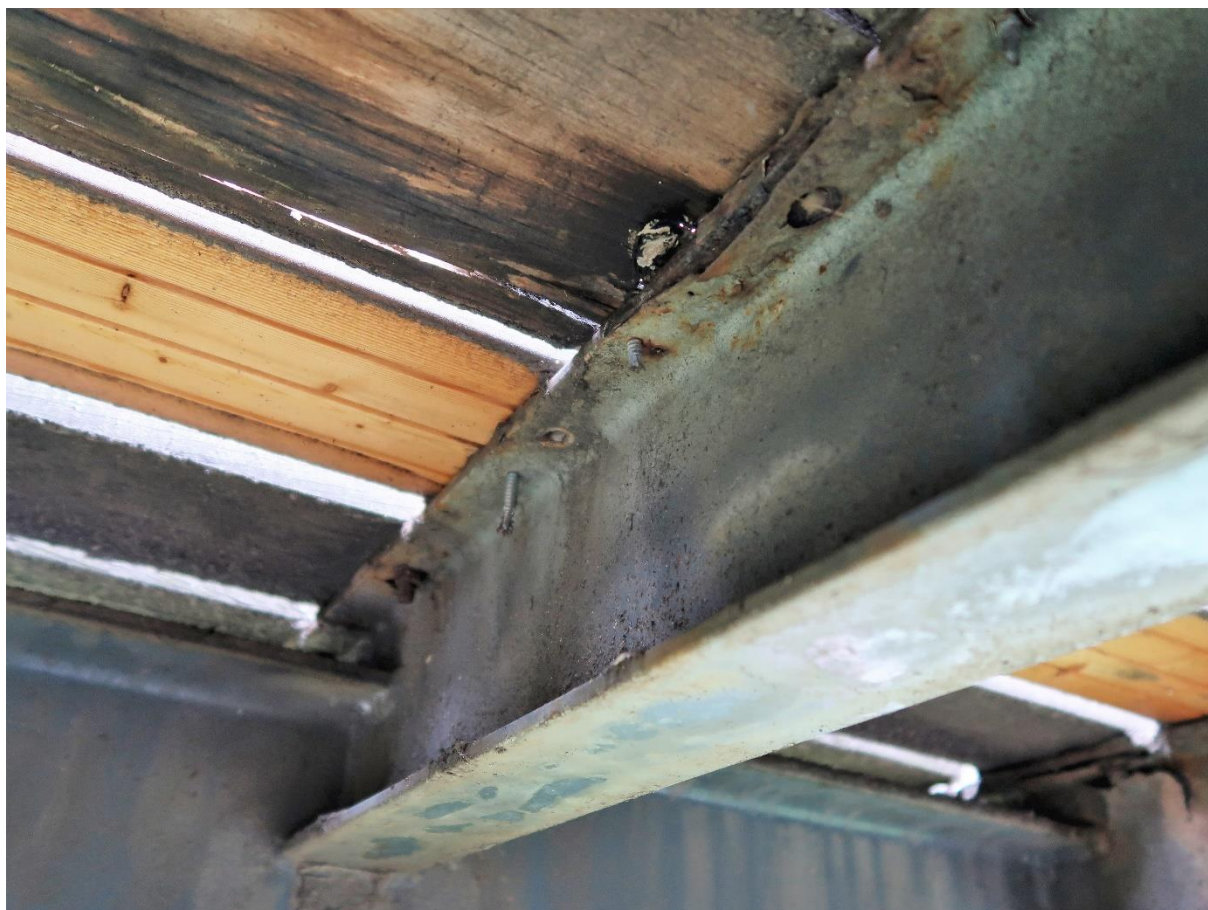
Obr.73 Pohled na detail připojení prken k podélníkům
