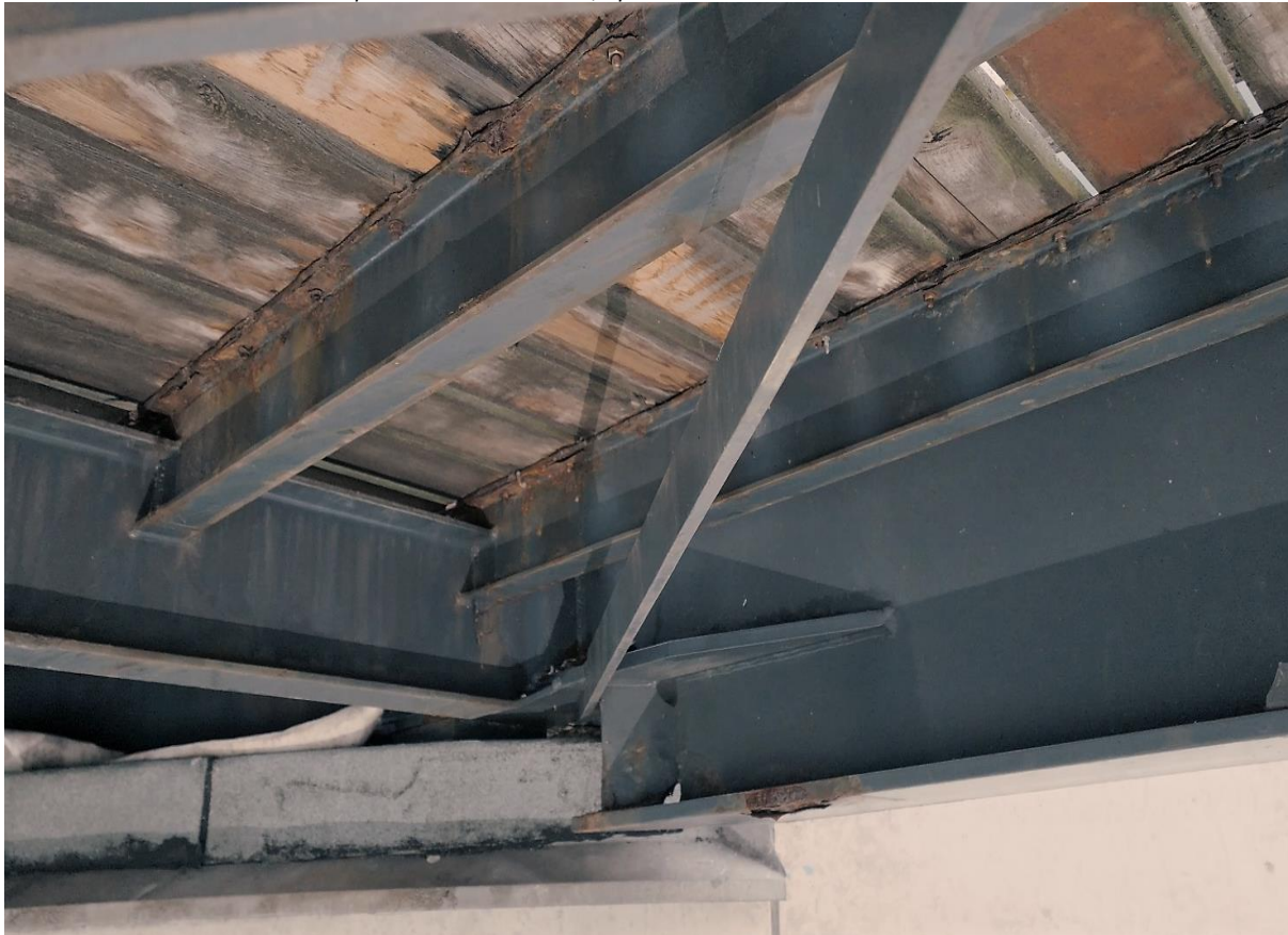
Obr.54 Pohled na uložení lávky vpravo na opěře 2, čtvrtá podpěra, nepřístupná
