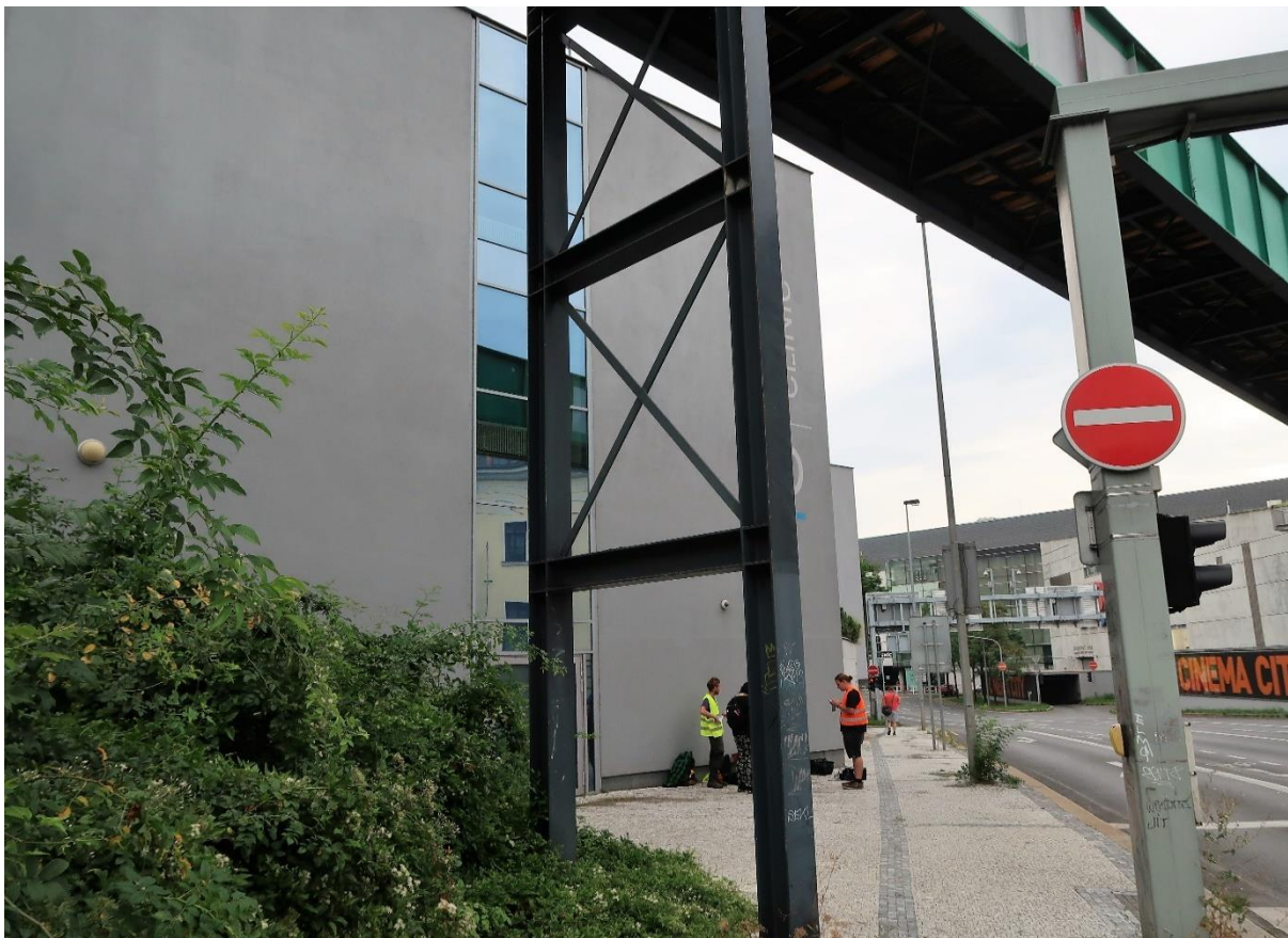
Obr.7 Pohled na graffiti prvního pilíře
