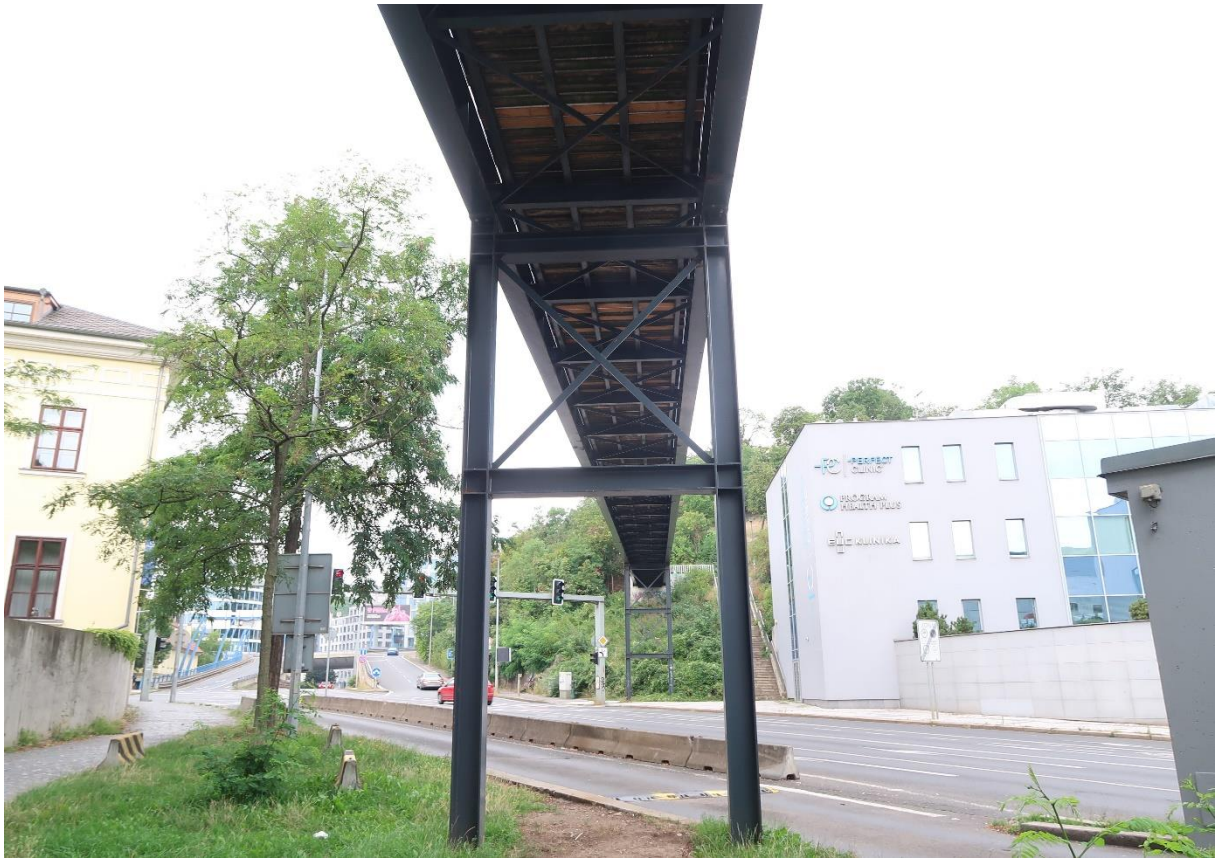
Obr.3 Pohled na třetí podpěru a druhý pilíř od KOC
