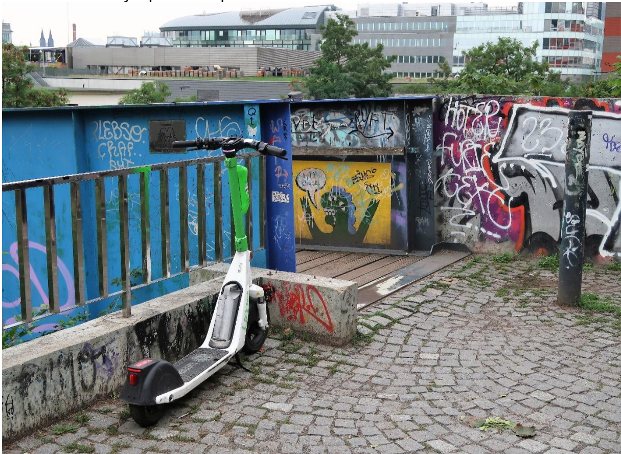
Obr.65 Pohled na mostní závěr opěra 1
