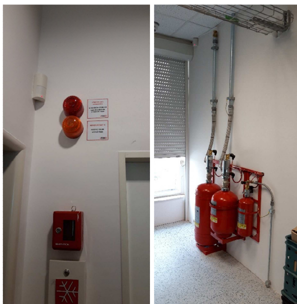
Obrázek 6: GHZ v prostoru serverovny
