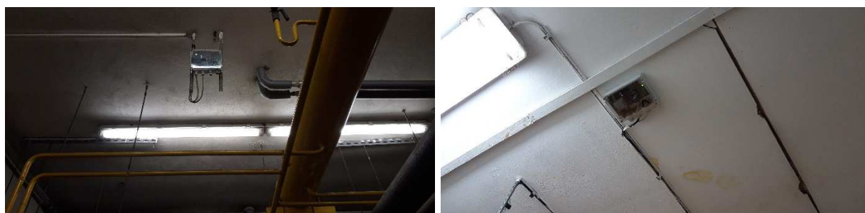
Obrázek 5: Detekce v prostoru plynových kotelů
