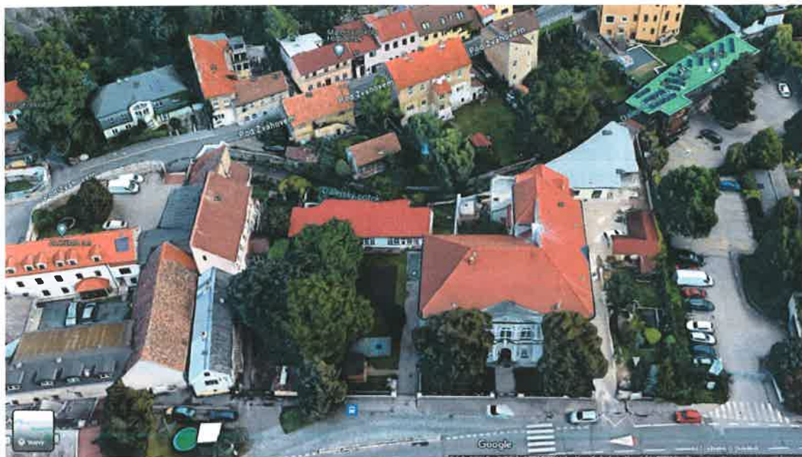
Letecký pohled na předmětný objekt
