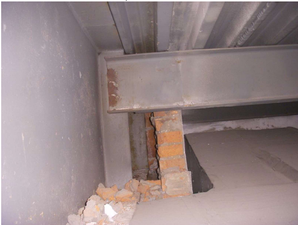
3...konstrukce stropu v místě 1
