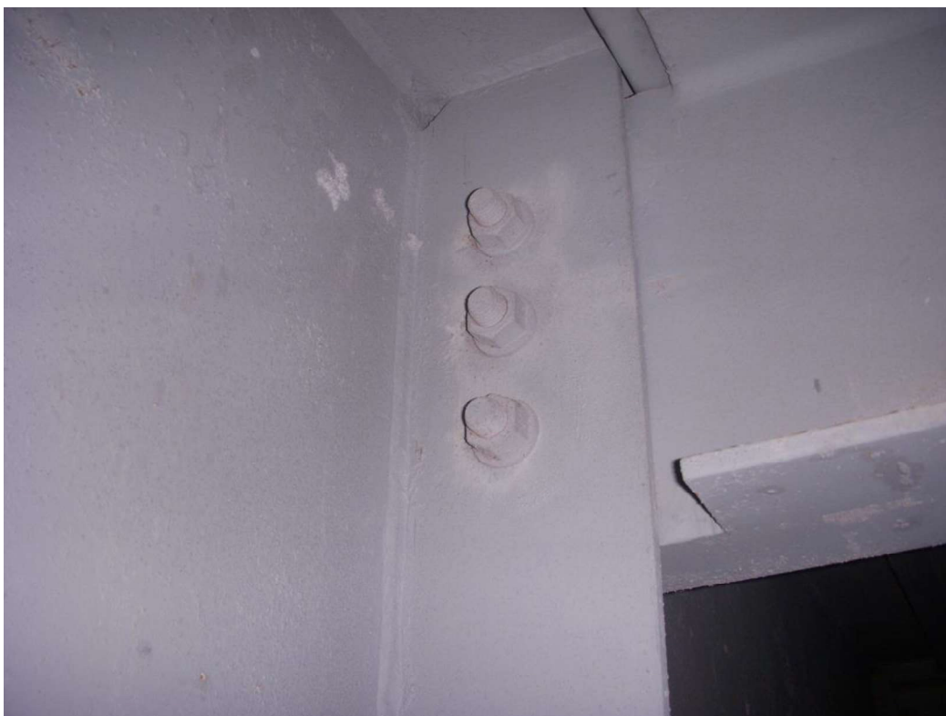
4...detail styku vazníku a vaznice v místě 1
