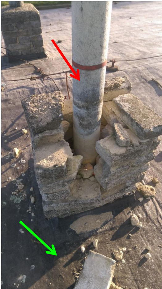
Foto č. 2 - Střecha objektu
