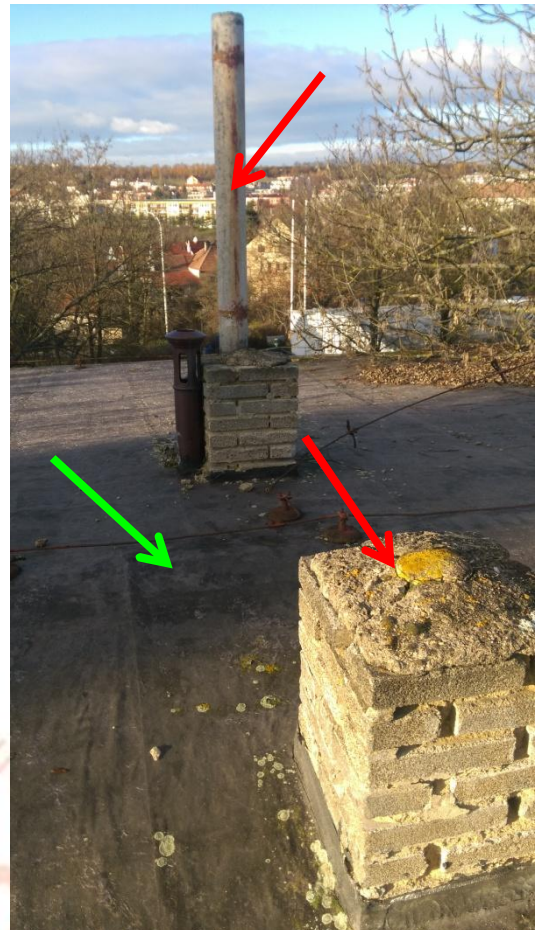
Foto č. 3 - Střecha objektu
