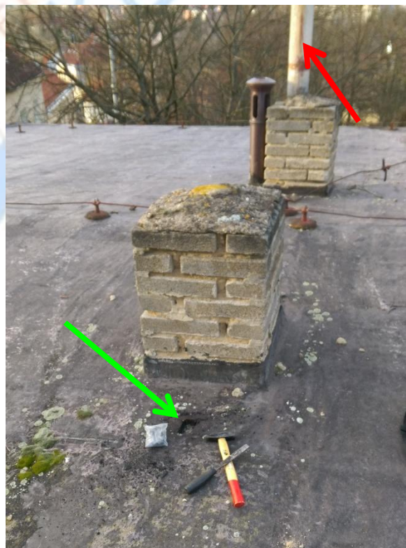
Foto č. 4 - Střecha objektu.
