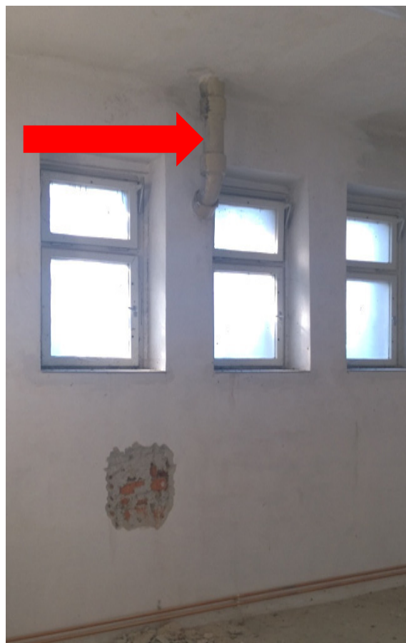
Obr. 5 Azbestocementová roura v jedné z místností ve 3.Np.
