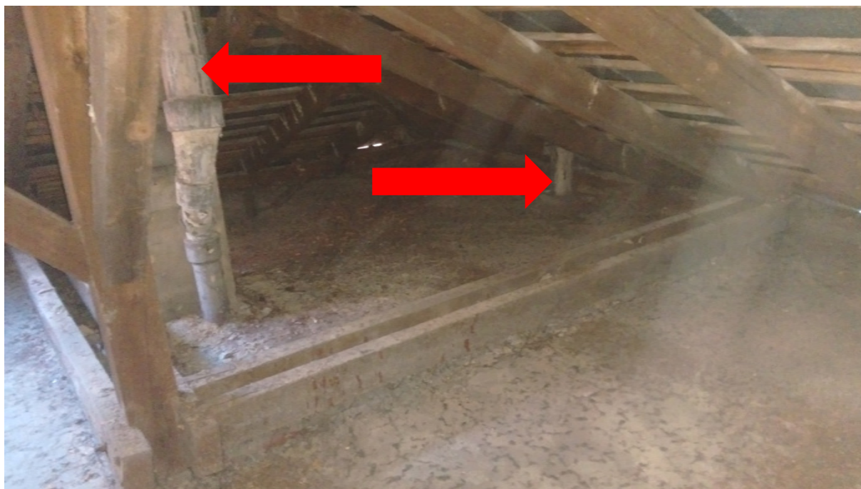
Obr. 3. Půda, azbestocementové roury jako kanalizační stoupačky.
