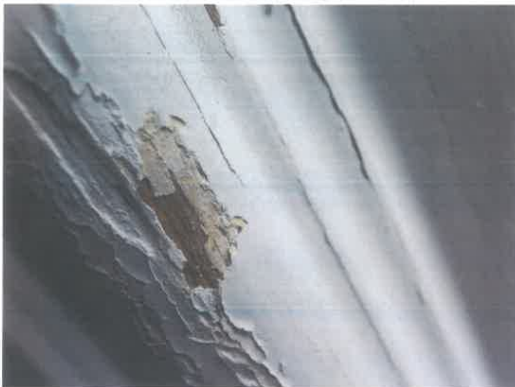
Sonda na okenním křídle ve druhém patře. Nejstarší nalezená barva v odstínu světlé slonové kosti.
