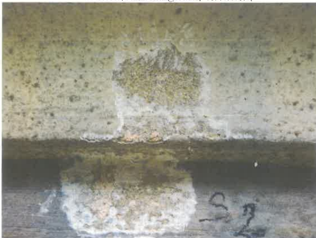
Sonda S2 – přízemí fasády na jižní straně. V horní části podokenní římsa, ve spodní části hladká plocha fasády. Průzkumem prokázány fragmenty okrového nátěru na štukovém podkladu.
