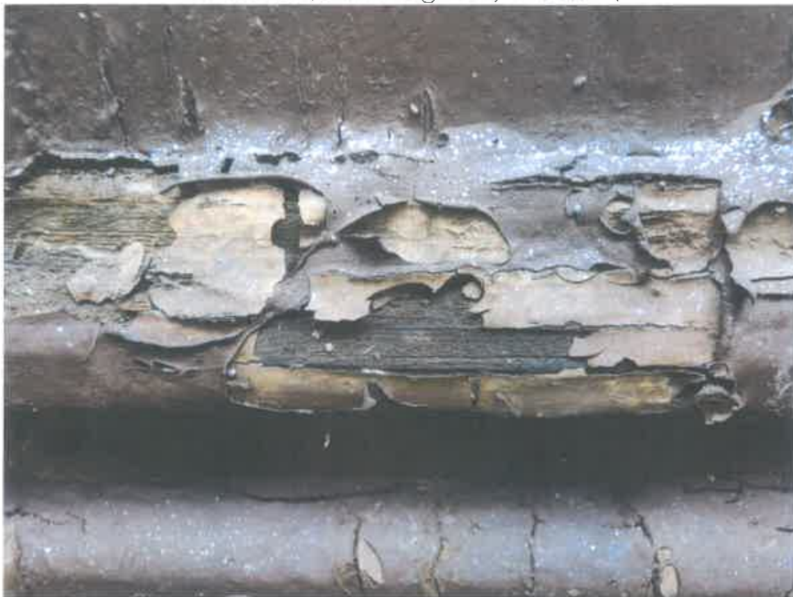
Detail stavu emailových nátěrů z vnější strany vstupních dveří .
