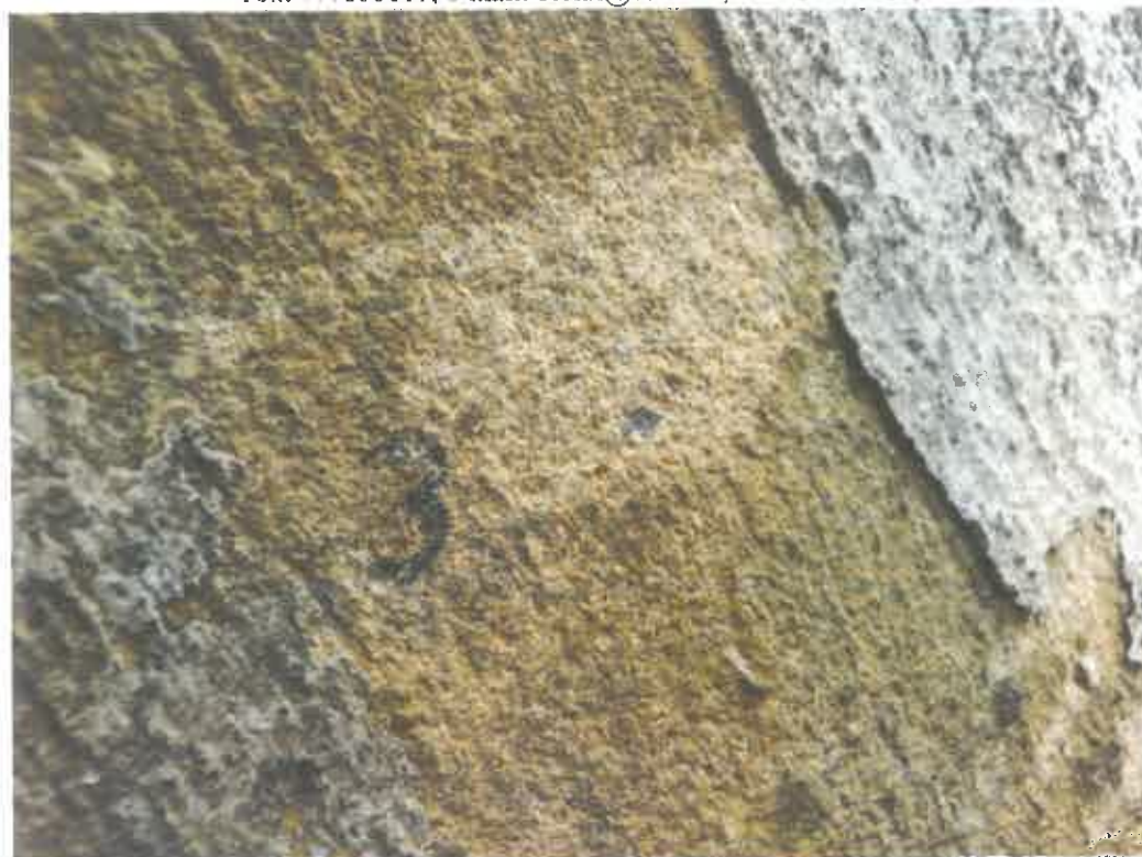
Sonda S3 – druhé patro severovýchodního koutu fasády. Pod stávajícím šedým nátěrem prokázána barva fasádního nátěru v okrovém odstínu na štukovém podkladu.
