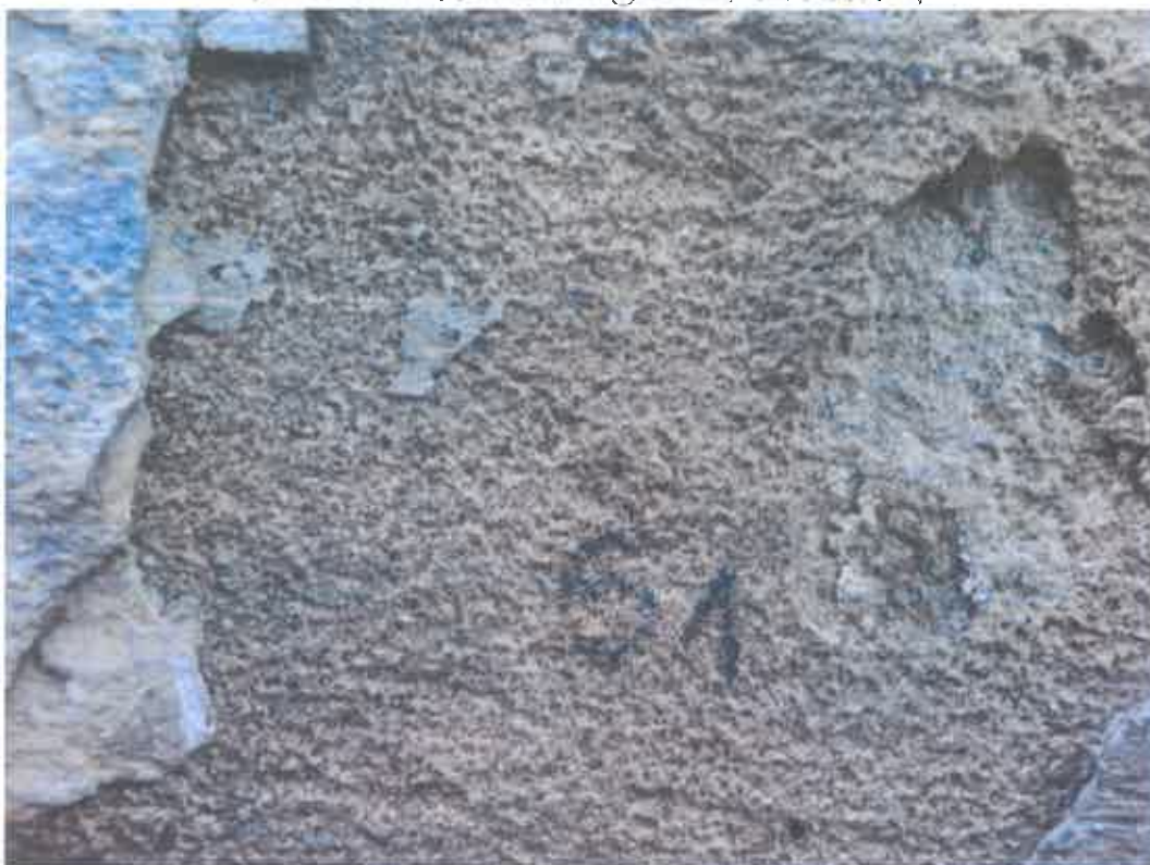
Sonda S1 – přízemí fasády na západní straně. Průzkumem nebyly prokázány starší barevné vrstvy.
