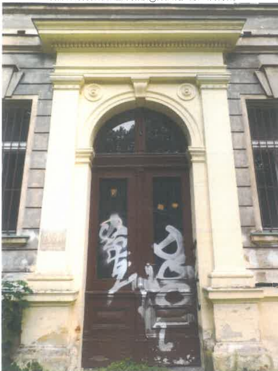
Vstupní dvoukřídle dveře se segmentovým proskleným nadsvětlíkem.
