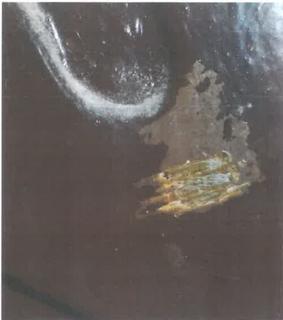
Sonda na kovovém závěsu vstupních dveří z vnitřní strany. Nález barevných vrstev se shoduje s předchozí sondou.
