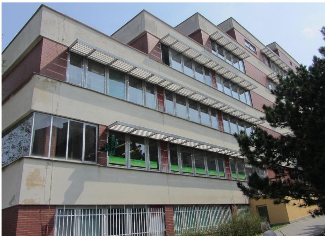
Severní vchod v místě spojení vyšší a nižší části, napravo od něj jsou v třípodlažní části již nová okna, zřejmě s vyztuženými meziokenními vložkami. Menší vstup ze severu do posilovny také nový.
