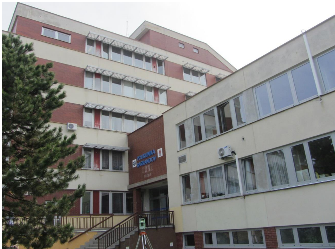
Severní vchod v místě spojení vyšší a nižší části, napravo od něj jsou v třípodlažní části již nová okna, zřejmě s vyztuženými meziokenními vložkami. Menší vstup ze severu do posilovny také nový.
