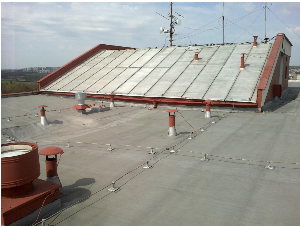
Střecha a terasa:
