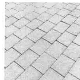
CHODNÍK DLAŽBA (beton)
