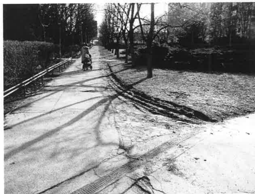
– úzká cesta - degradované povrchy – odvodnění – plůtky
