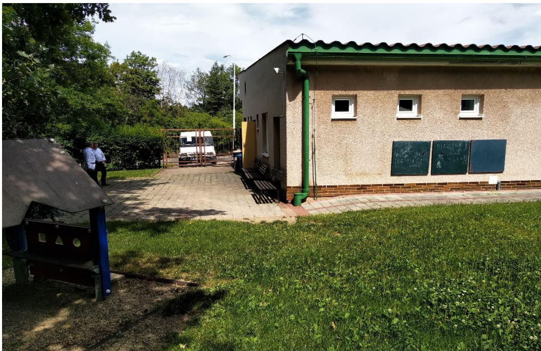
Pohled na prostor vjezdu zásobování
