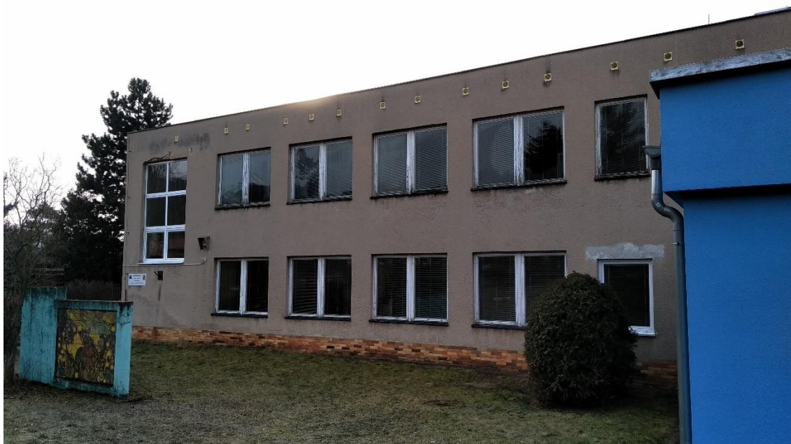
Pohled na severní stranu části objektu s třídami
