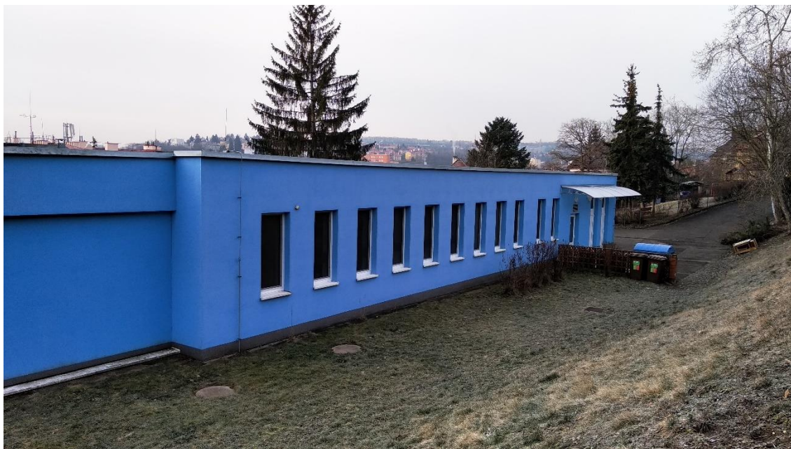
Pohled na severní fasádu hospodářského objektu
