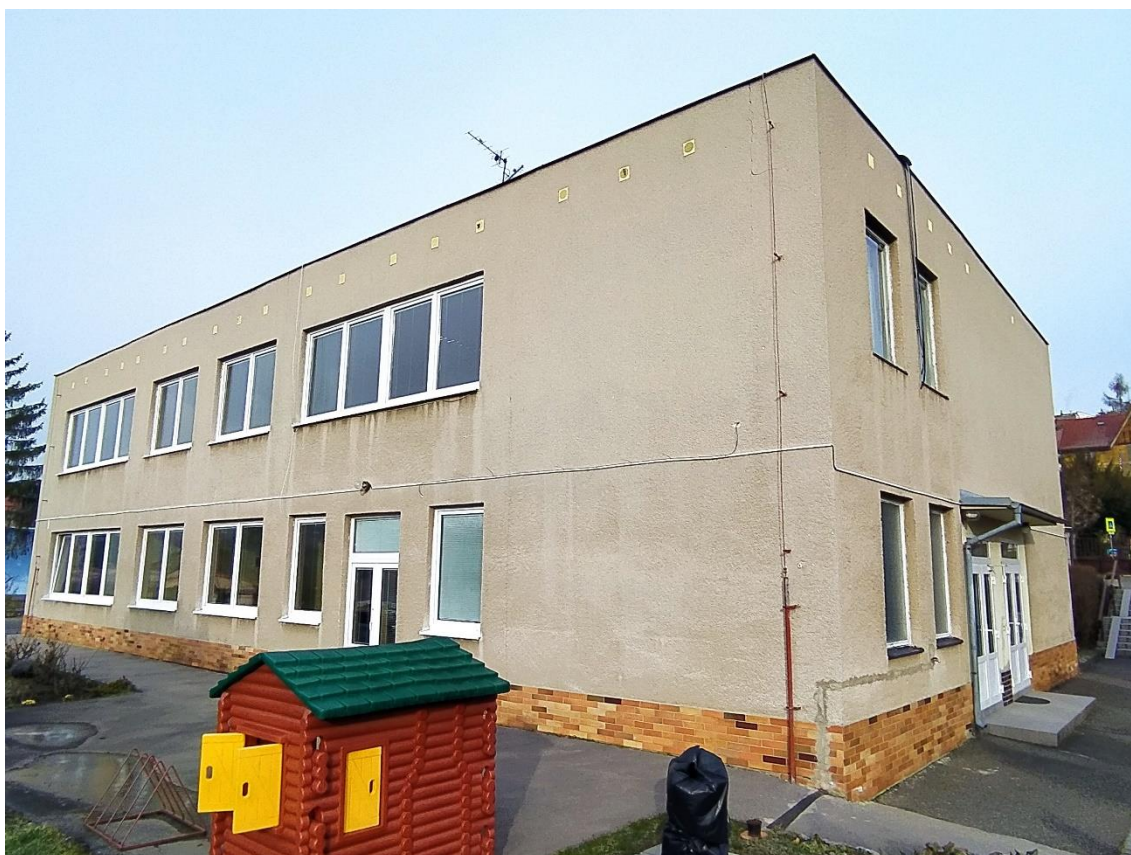
Pohled na jižní část objektu s třídami
