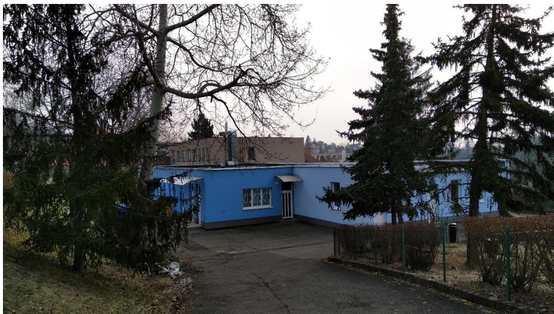
Pohled od zásobovacího vjezdu
