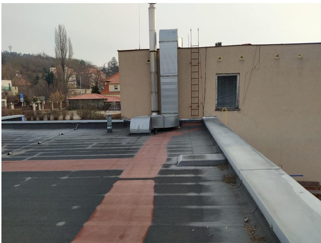
Střecha zrekonstruovaného hospodářského objektu
