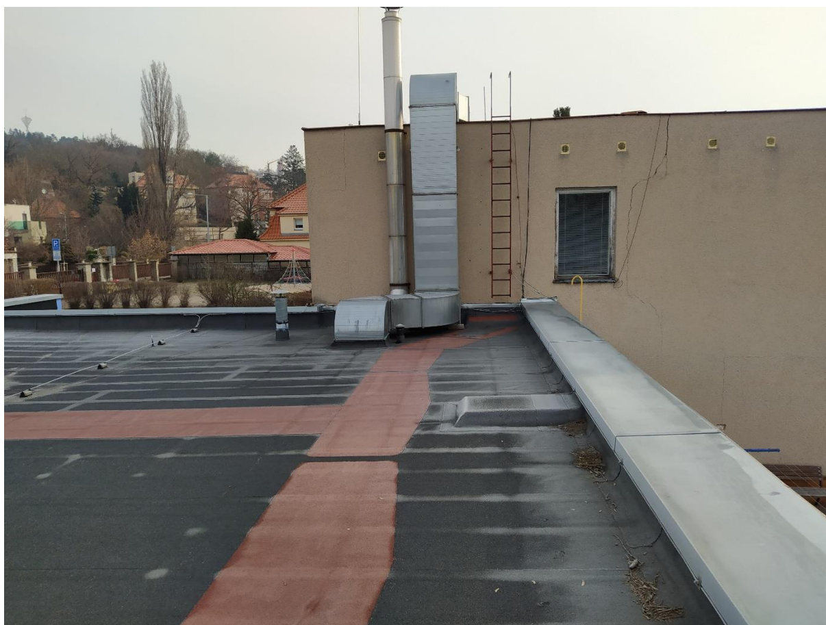
Obrázek 4 – Nová střecha + nutná přeložka komínu a vzduchotechniky:
