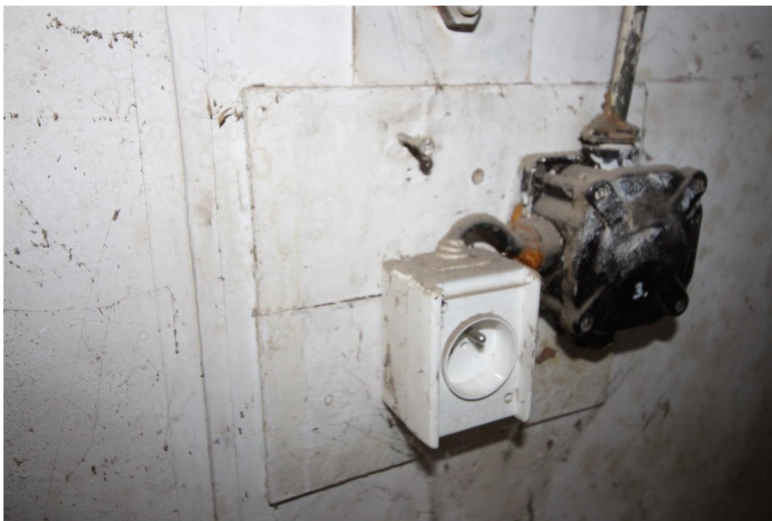
Foto 041 – podložka pod elektroinstalacemi
