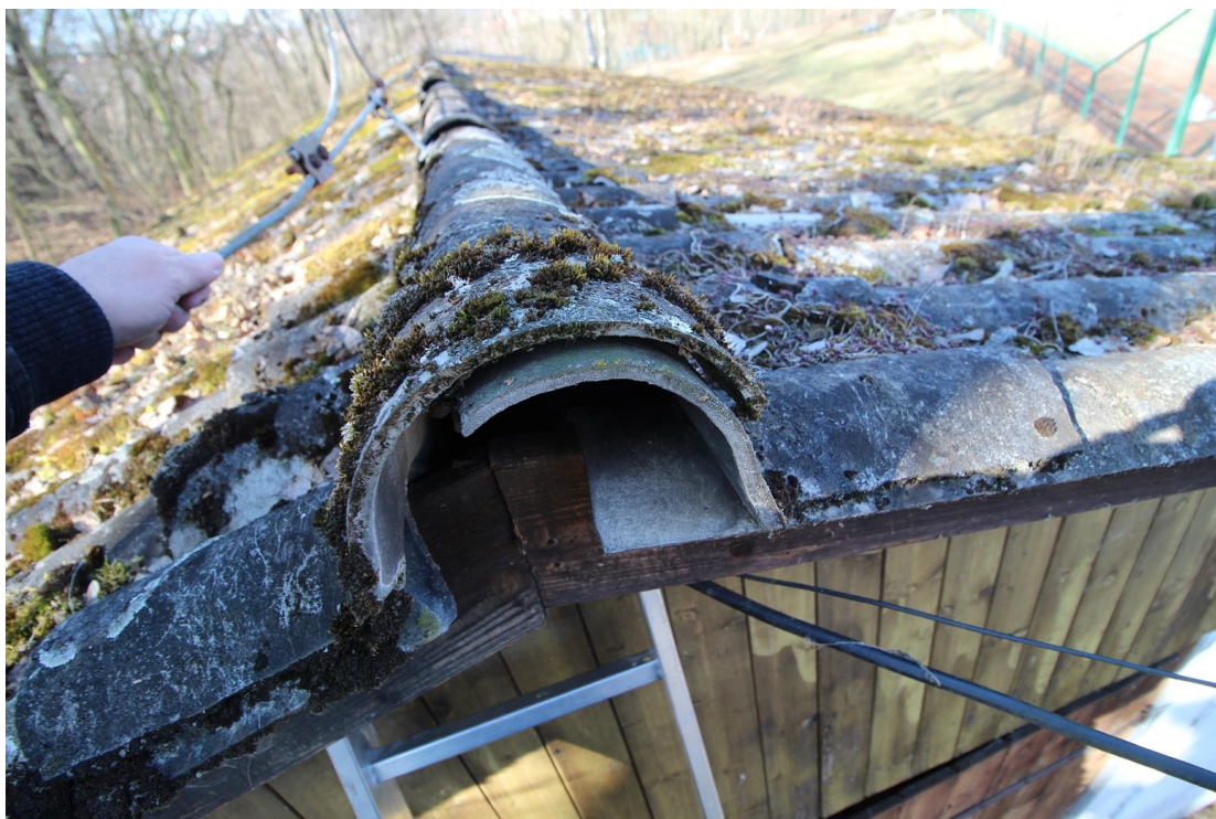
Foto 054 – střešní krytina z vlnitého eternitu – odběr vzorku VZ6
