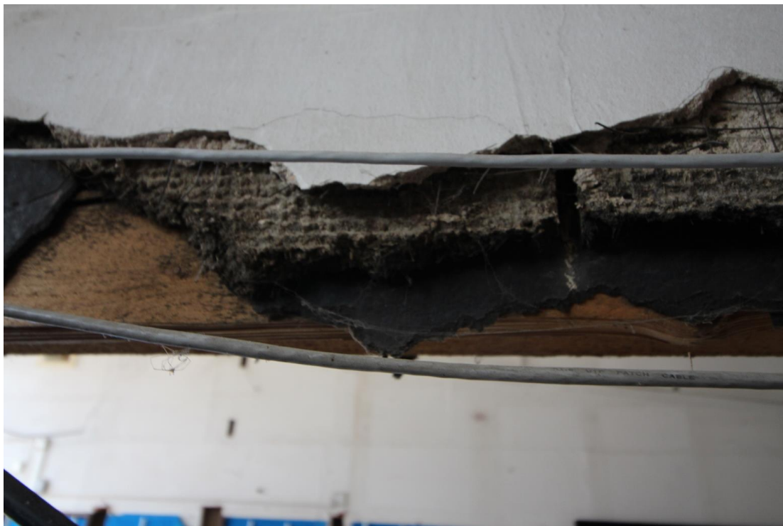
Foto 003 – odběr vzorku VZ1 – deskový materiál obložení vnitřních příček
