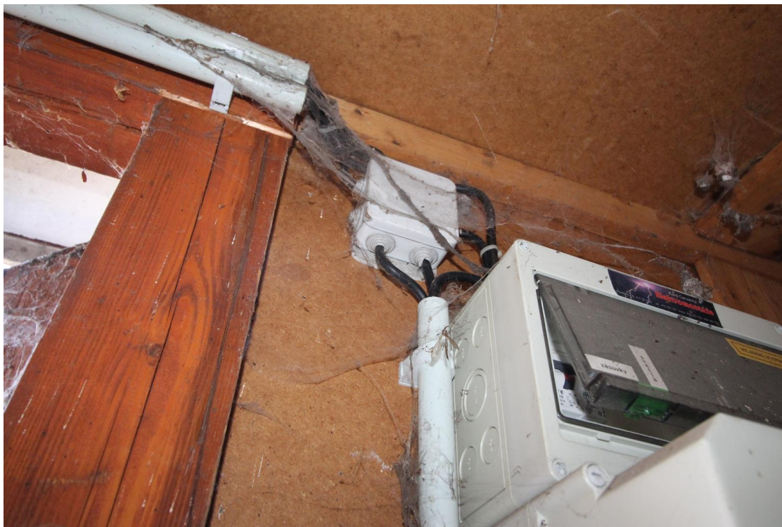
Foto 057 – podložky pod elektroinstalacemi, nebyl odebrán vzorek, jedná se o stejný materiál, jako v případě restaurátorské dílny
