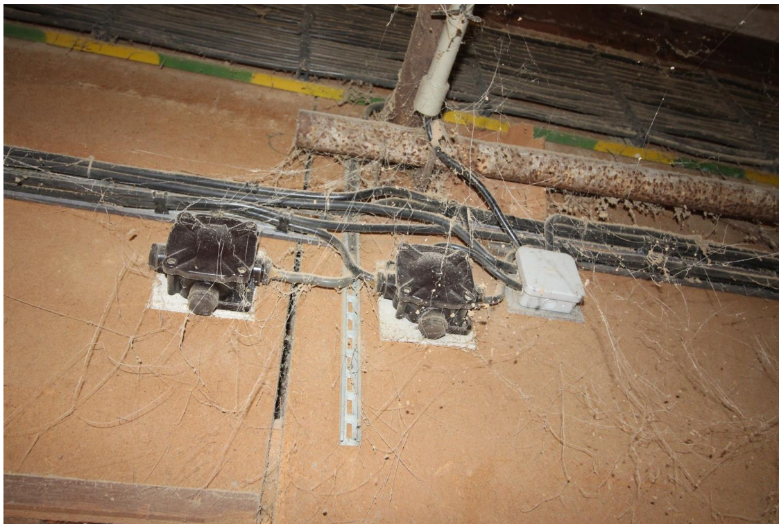
Foto 045 – podložky pod elektroinstalacemi
