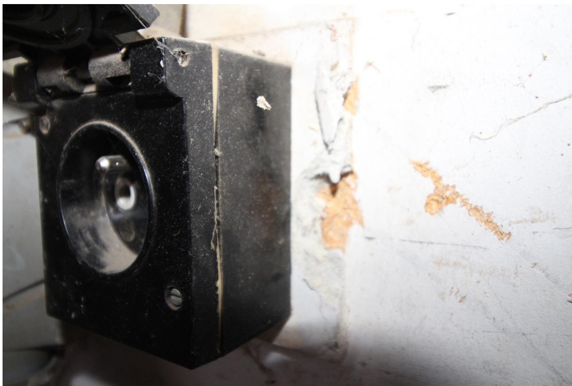
Foto 037 – odběr vzorku VZ4 – podložka pod el. zásuvkou
