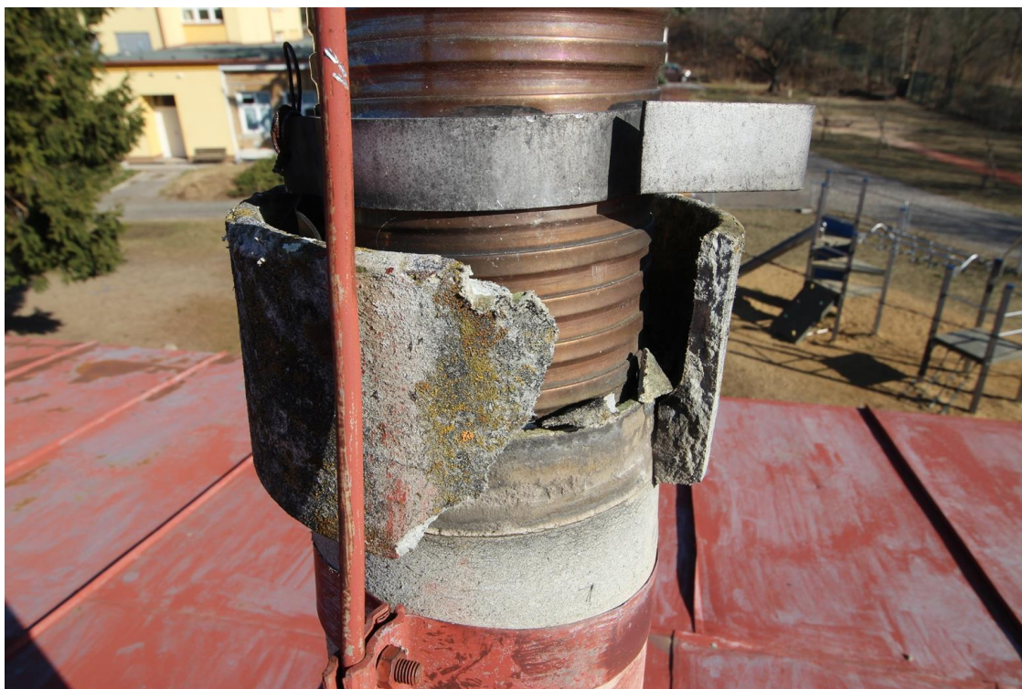
Foto 021 – odběr vzorku VZ3 – hlavice odvětrávacího komínku
