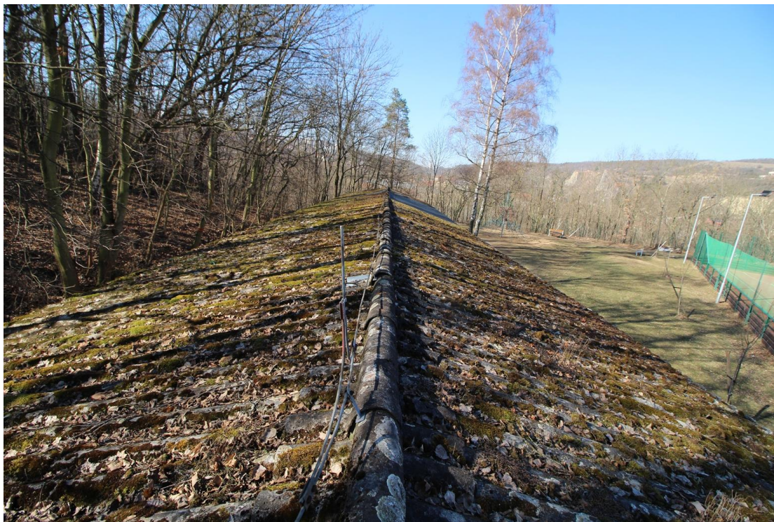
Foto 053 – střešní krytina z vlnitého eternitu – odběr vzorku VZ6
