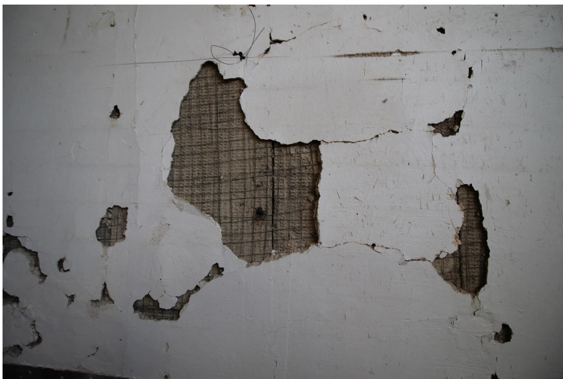
Foto 012 – deskový materiál obložení vnitřních příček
