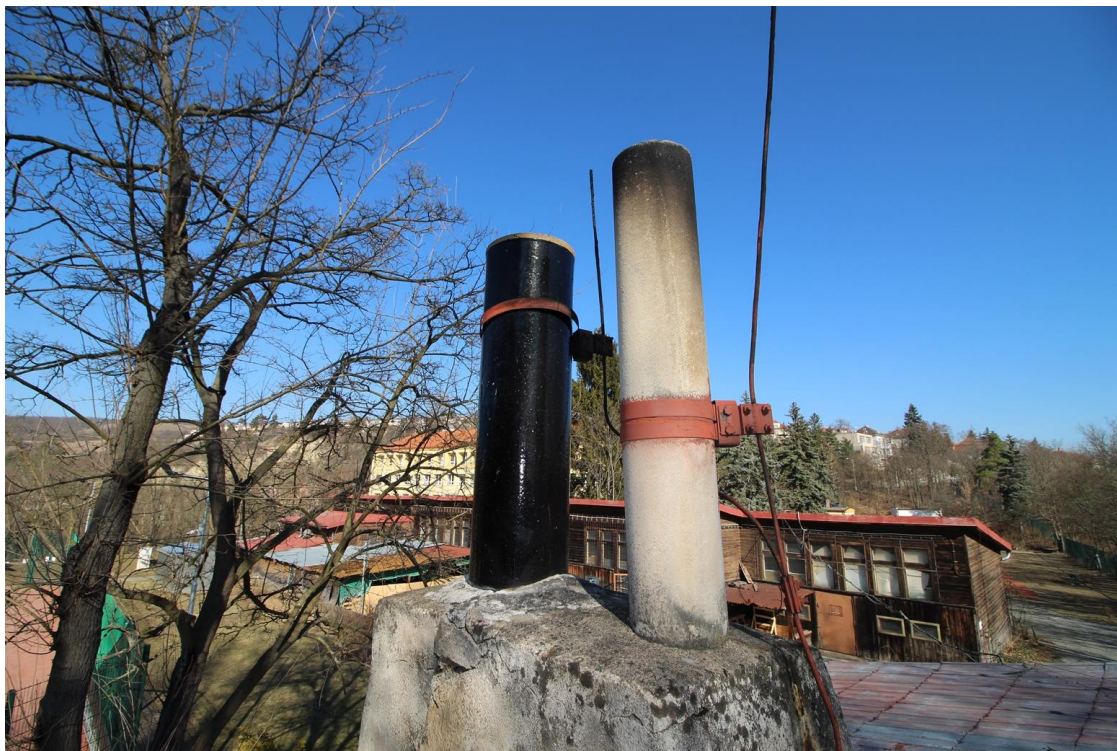
Foto 035 – odběr vzorku VZ5 – hlavice odvětrávacího komínku
