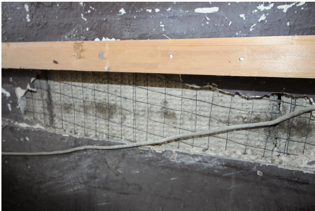
Foto 010 – deskový materiál obložení vnitřních příček
