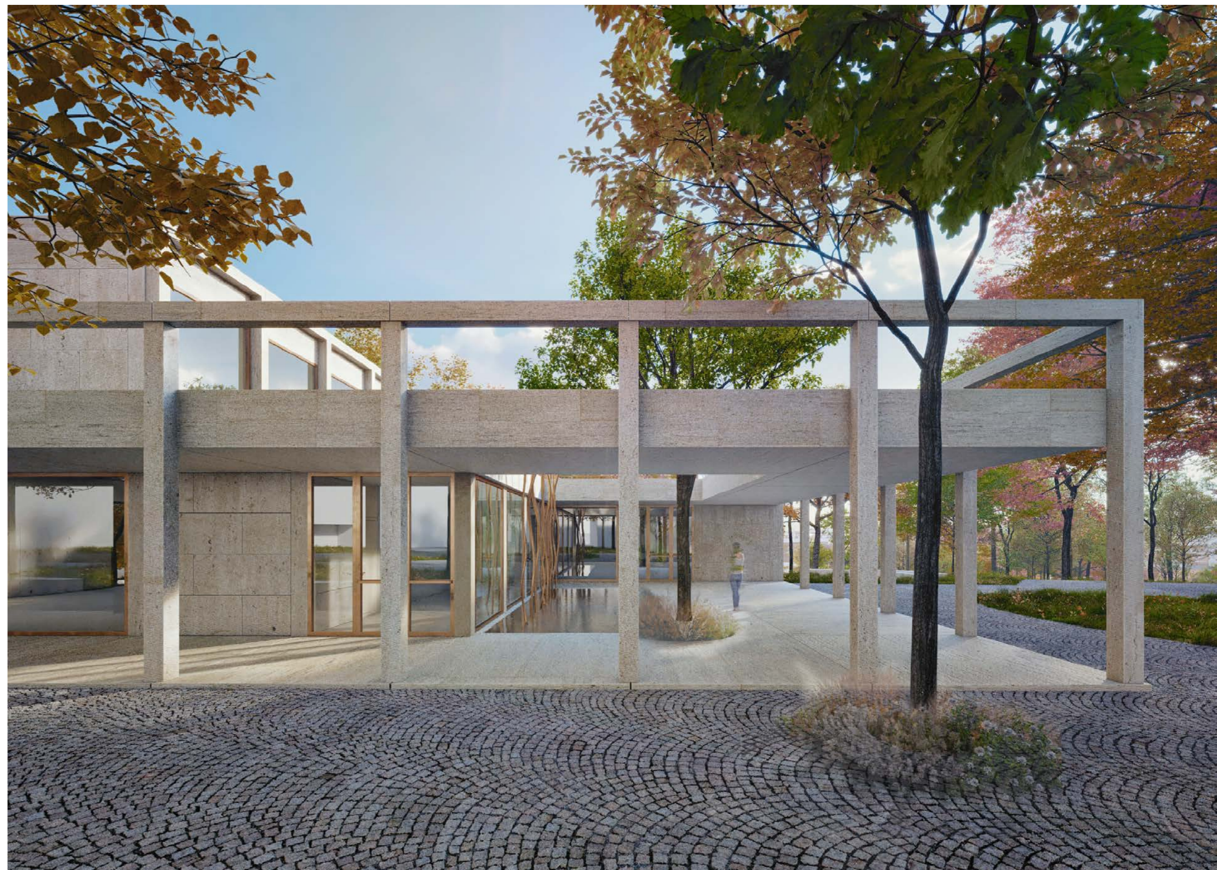
POHLED NA VSTUP A DO ATRIA
