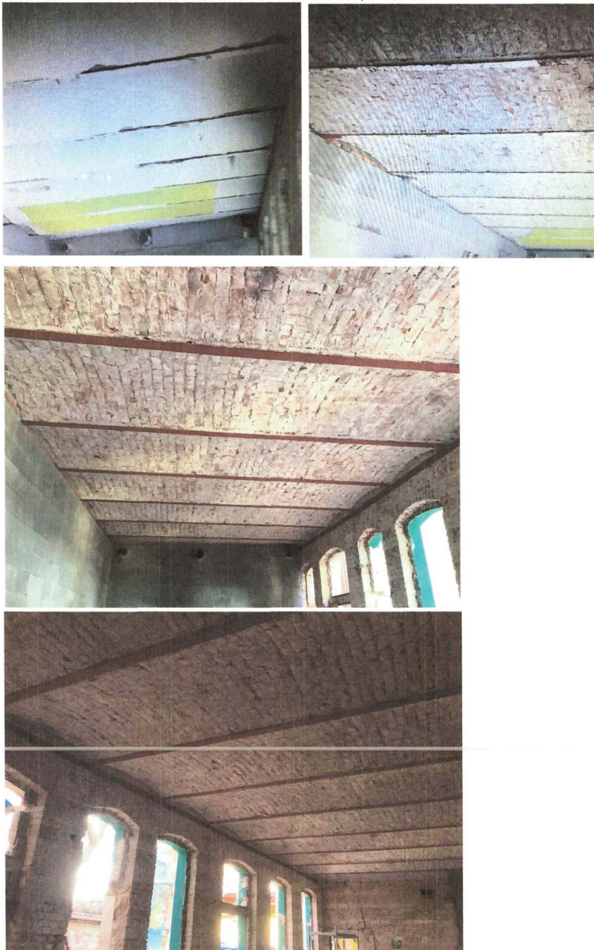
Příloha č.3 : Fotodokumentace antikoroziního nátěru ocelových nosníků
