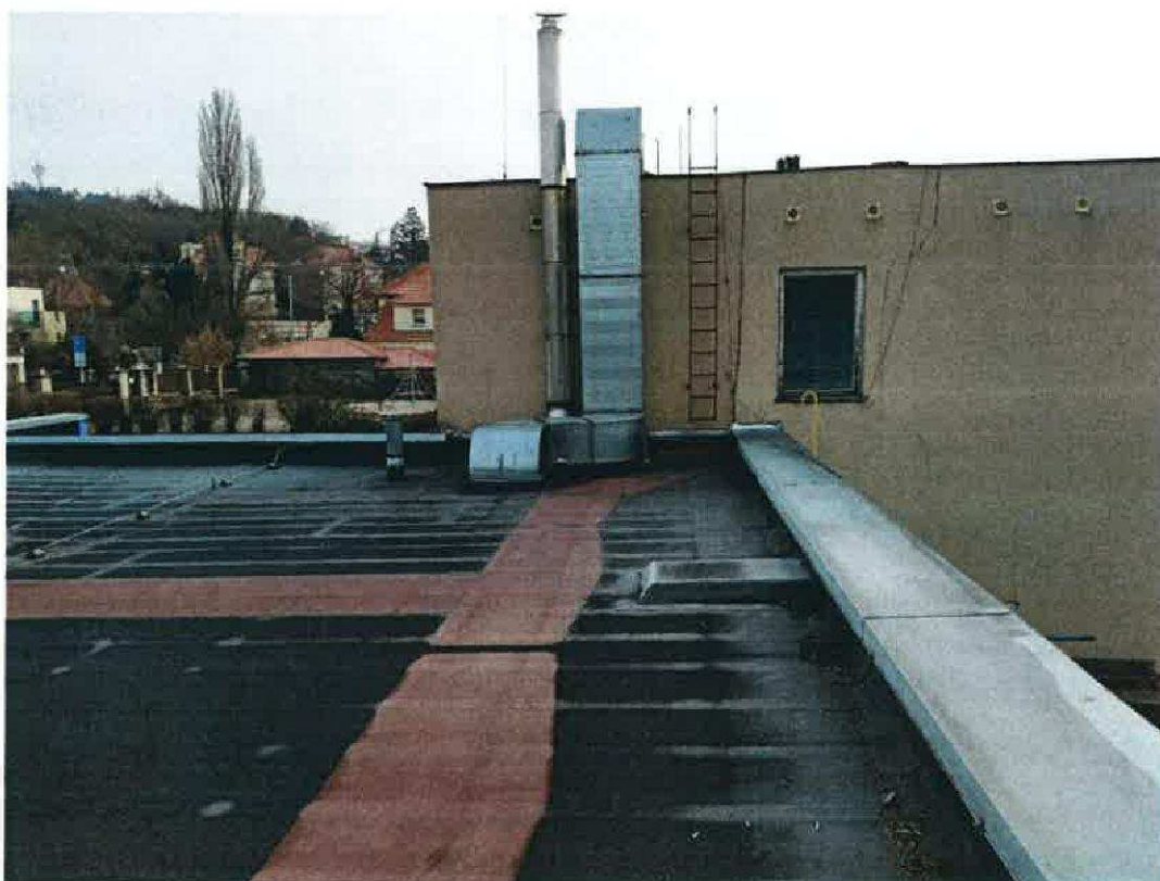
Střecha zrekonstruovaného hospodářského objektu
