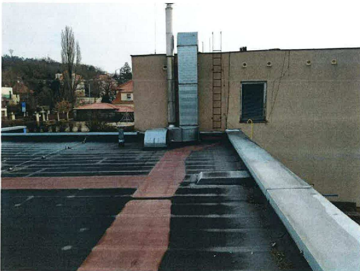
Obrázek 4 – Nová střecha + nutná přeložka komínu a vzduchotechniky:
