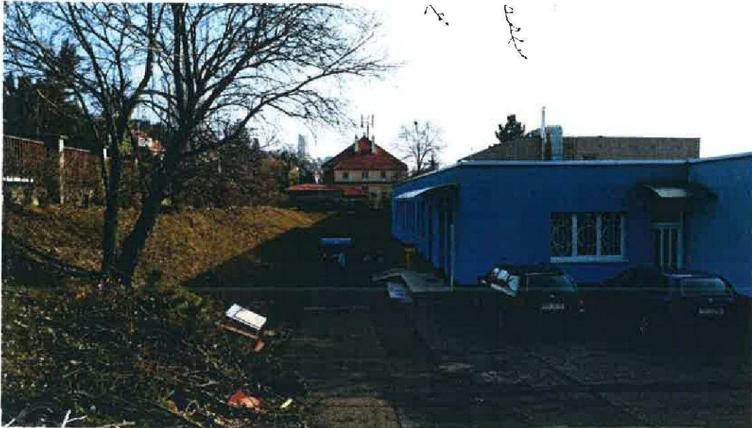
Pohled na prostor zásobování kuchyně
