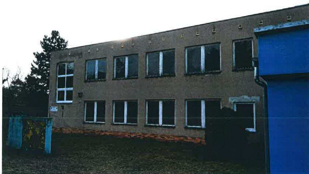
Pohled na severní stranu části objektu s třídami
