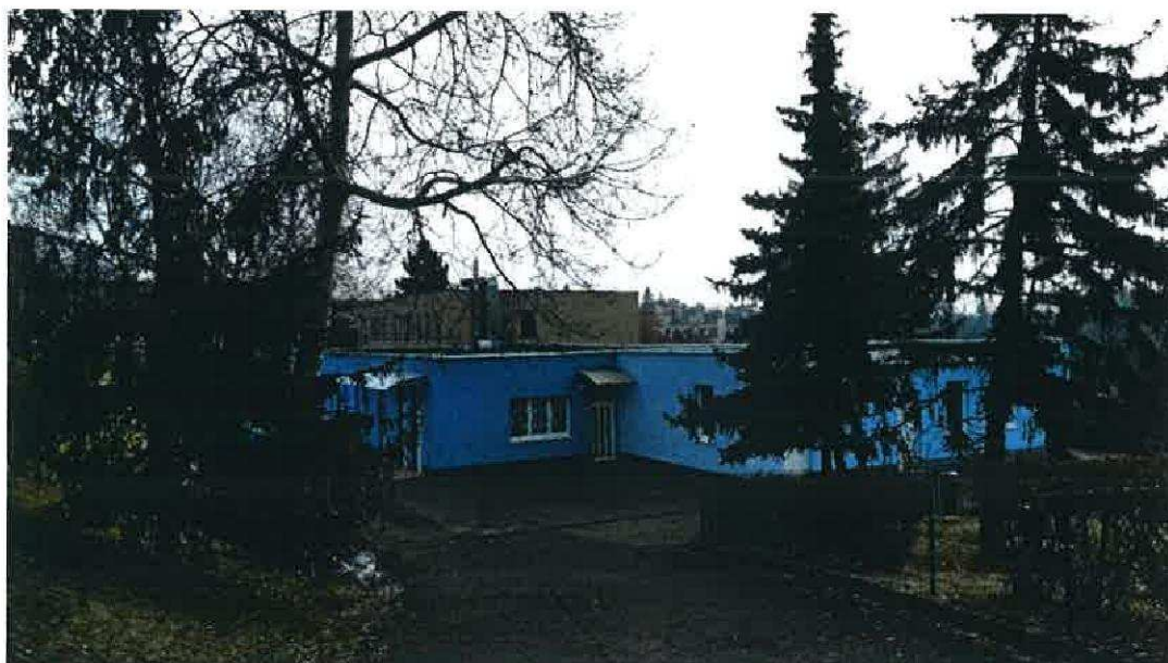
Pohled od zásobovacího vjezdu
