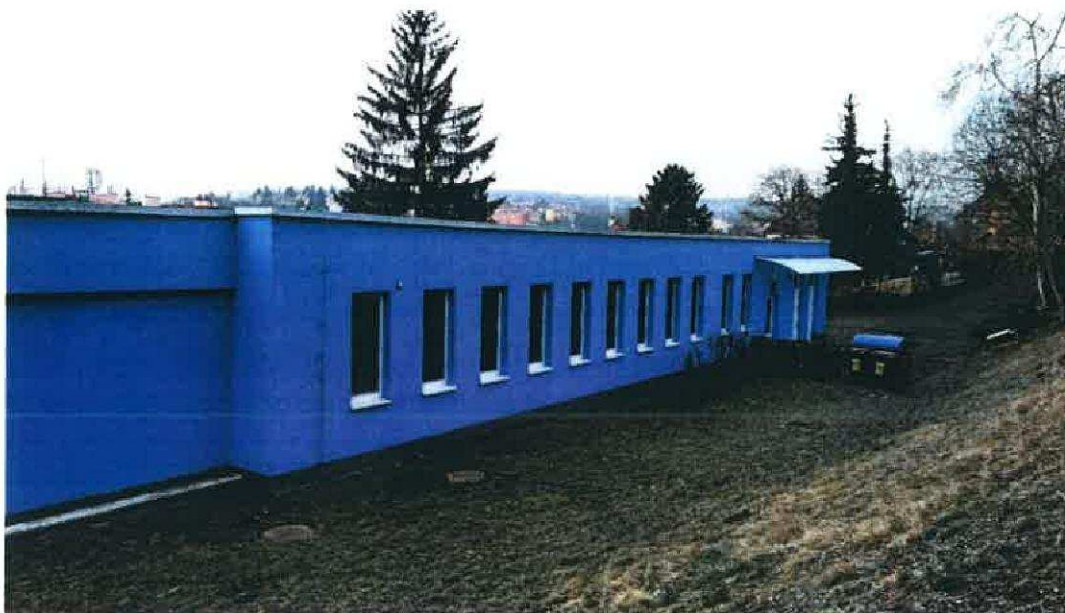
Pohled na severní fasádu hospodářského objektu
