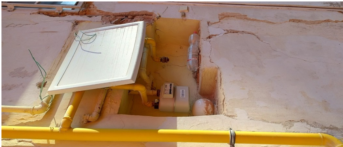
Příloha č.6: fotodokumentace meziokenního pilíře na dvorní fasádě mezi byty č.7 a č.8 ve 3.NP
