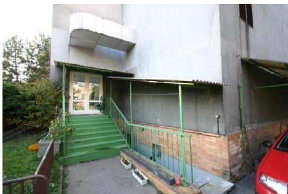
obr. 9 Kabřincový obklad suterénu - jižní fasáda
