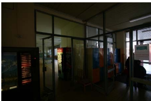
obr. 15 Ocelohliníková dělicí stěna ve vestibulu
