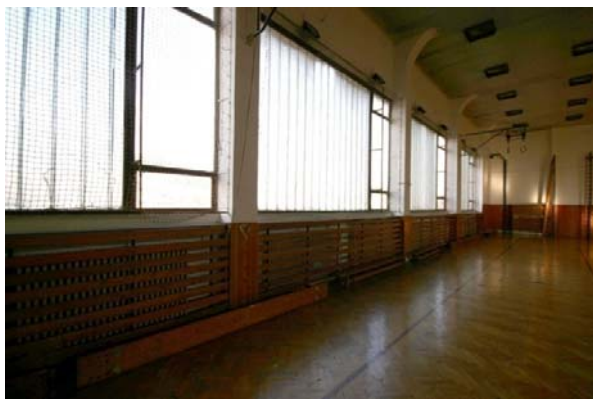
obr. 11 Ocelová okna a copilit v tělocvičně
