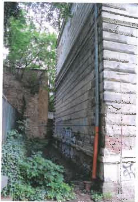
Degradace a opadávání fasády
