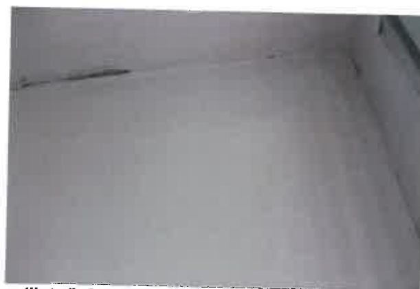
dilatační trhliny mezi příčkou a bet. stropem
