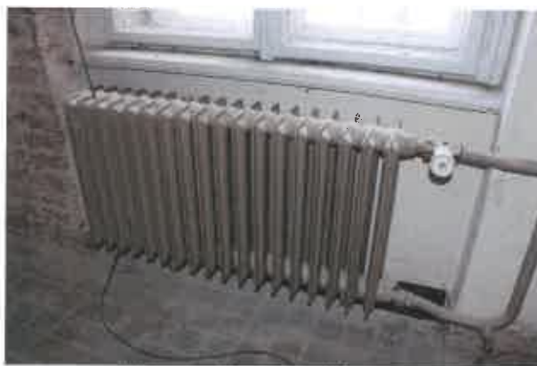
litinové těleso radiátoru
