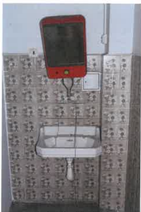
lokální ohřivač teplé vody
