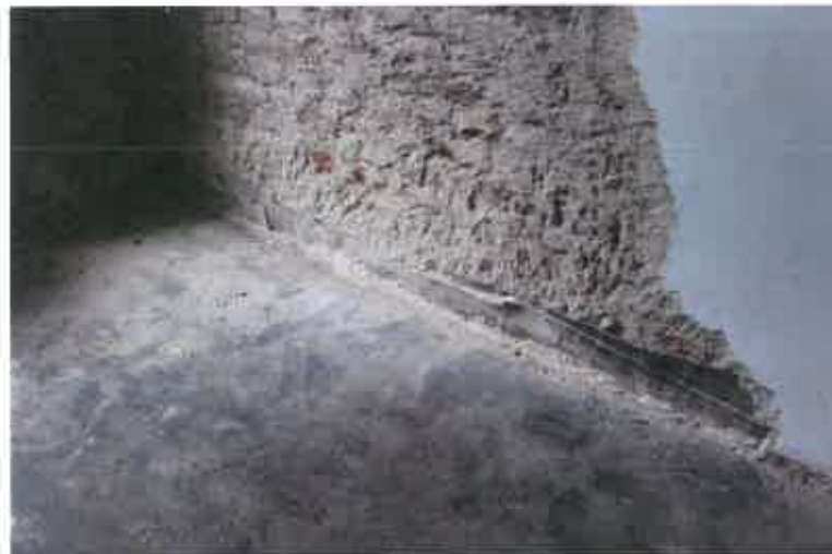
Napojení hydroizolace na stěny
