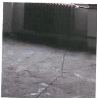
dilatační trhlina bet. mazaniny podlahy ve 2.NP
