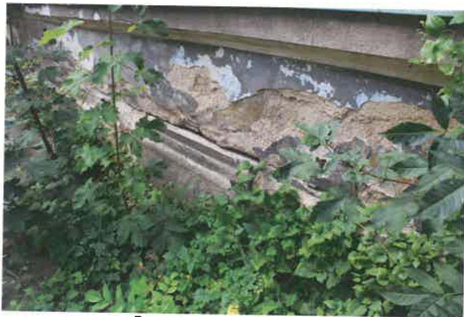
Degradace a opadávání soklu
