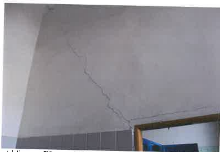
trhliny v příčce, oddělující mezi chodbou a WC ve 2.NP
