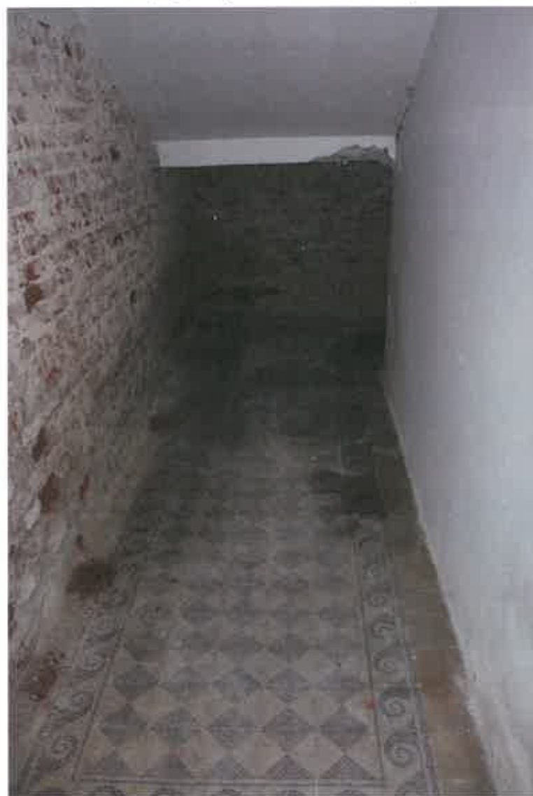
vlhkost konstrukci pod hl. schodištěm
