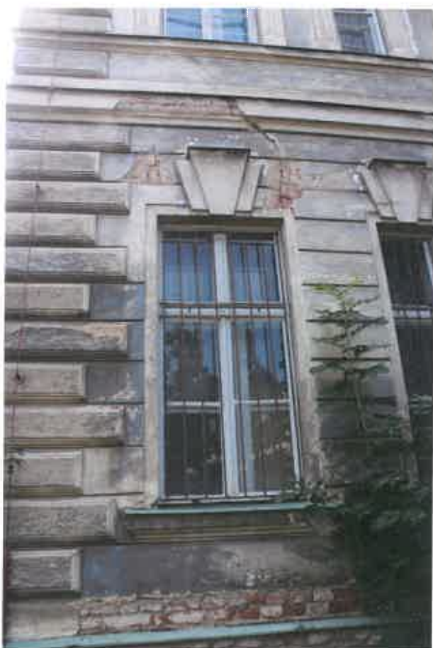
trhliny v levé části sev. fasády
