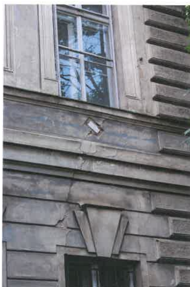
trhliny v pravé části sev. fasády
