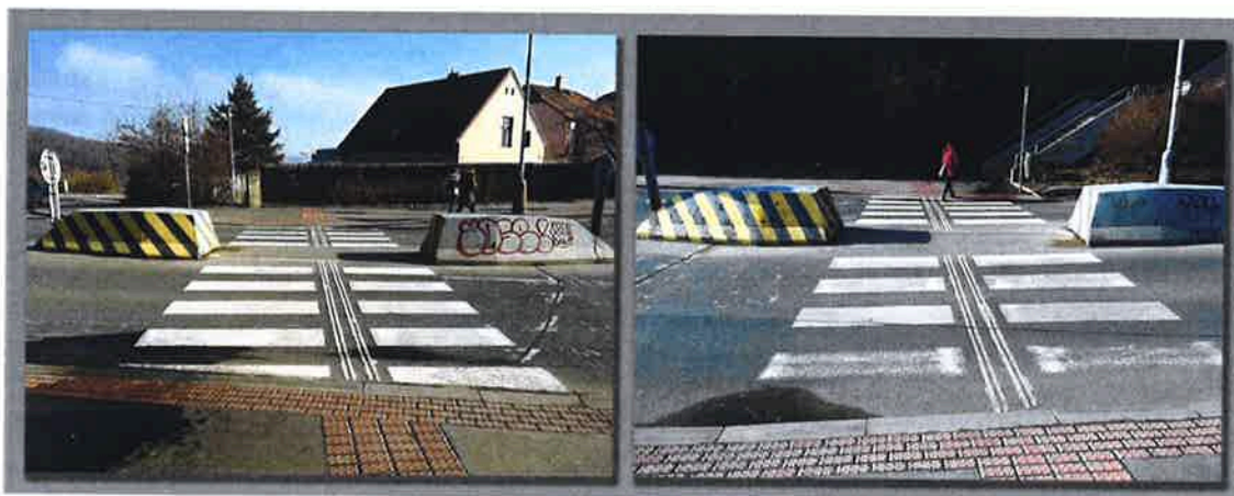
Obrázek 3: Stavební řešení přechodu
